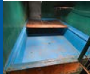
Es liegt noch viel Arbeit vor uns, bis Hunde im Becken schwimmen können
